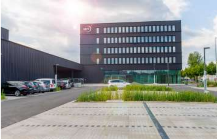
Neubau des Dt. Biomasseforschungszentrums in der Torgauer Straße; Foto: DBFZ
